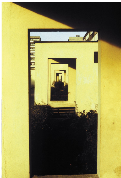
Fot. 16. Białystok, rehabilitacja bokowiska; betonowe podcienia przybudowane do wejść w klatki typowych bloków, stwarzają nowe wartości pod względem funkcjonalnym i estetycznym; architekt Henryk Toczydłowski (fot. H. Toczydłowski)
