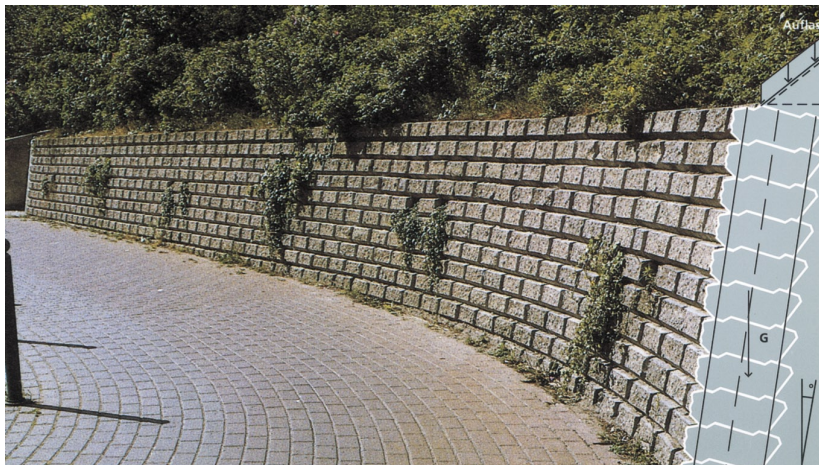
Fot. 14. Mur oporowy z prefabrykowanych elementów betonowych, nieco przypominających naturalne kamienie [1]
