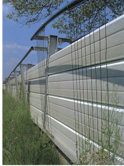
Fot. 12. Nowoczesny ekran antyakustyczny z betonowych płyt rowkowanych wsuwanych w metalowe słupki o przekroju litery „H” [6]
