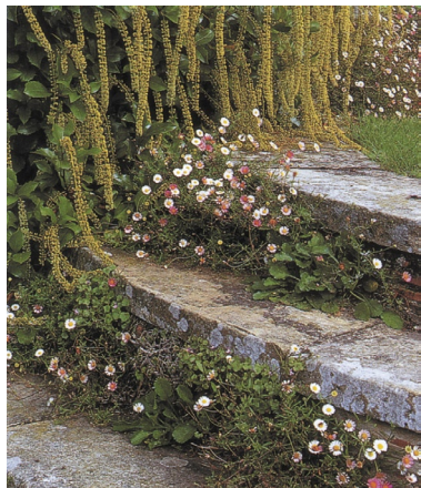
Fot. 23. Betonowe schody ogrodowe patynują się idealnie przypominając kamień naturalny [5]
