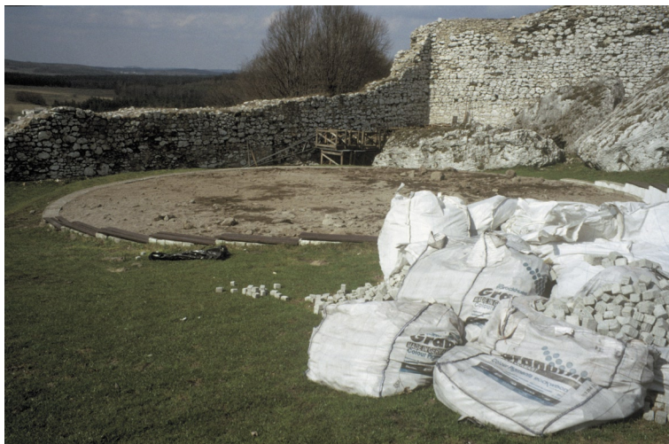
Fot. 7. Ogrodzenie; dziedziniec w ruinach zamczyska przygotowany do wyłożenia kostką (fot. W. Kosiński)
