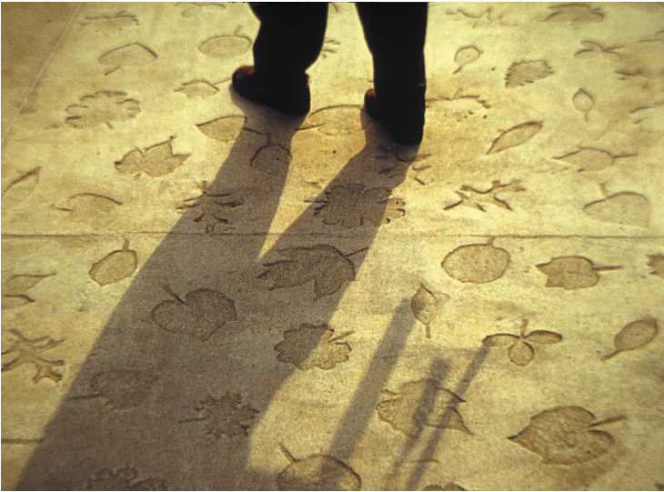
Fot. 22. Beton dzięki łatwości utrwalania negatywów powstałych wskutek odciskania zadanych form modelowych, jest wyjątkowo wdzięcznym tworzywem dla tworzenia nieco ekstrawaganckich tarasów (archiwum A. Böhmabb)
