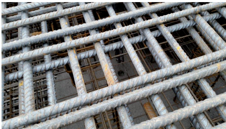
Fot. 1. Konieczność przygotowania miejsc do wprowadzenia węża pompy
