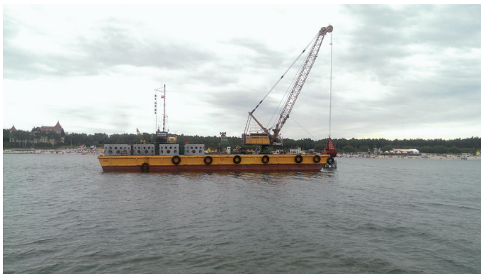
Fot. 5. Montaż siedlisk
