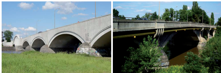
Fot. 11. Jedne z pierwszych żelbetowych mostów łukowych Wrocławia, od lewej: stary most Warszawski (1916) – fot. J. Biliszczuk i mosty Bolesława Chrobrego (1917)
