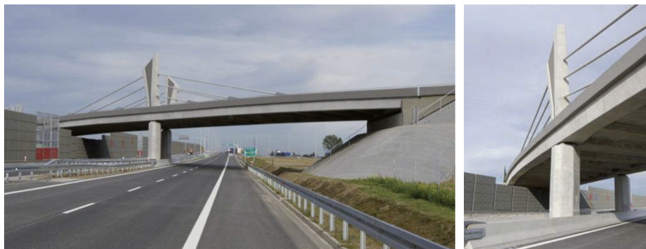
Fot. 3. Wiadukt nad drogą ekspresową S8 niedaleko Oleśnicy (projekt: Zespół Badawczo-Projektowy Mosty-Wrocław)
