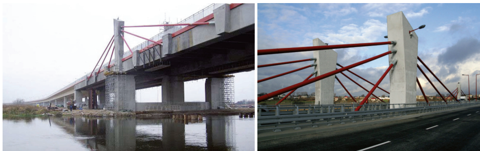
Fot. 1. Most w Koninie – widok podczas budowy oraz widok z pomostu
