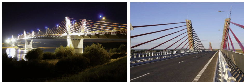
Fot. 5. Most w Kwidzynie – widok podczas budowy oraz ukończona konstrukcja (zdjęcie: Budimex S.A.)
