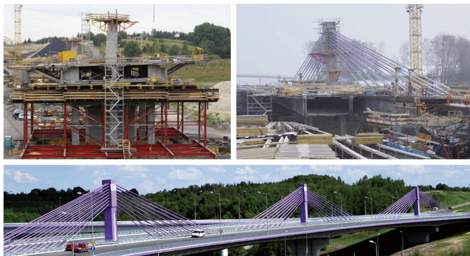
Fot. 4. Most w Mszanie – budowa i widok ukończonego mostu (zdjęcie: M. Prusak)
