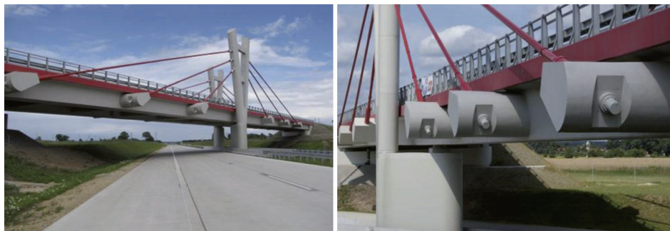
Fot. 2. Widok ukończonego wiaduktu w Wykrotach (projekt: Zespół Badawczo-Projektowy Mosty-Wrocław)
