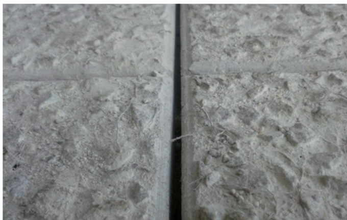
Fot. 5. Fazowanie dylatacji
