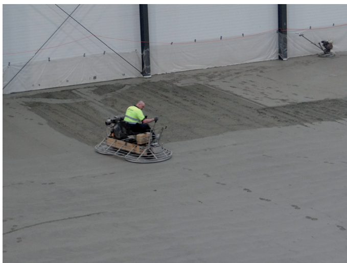
Fot. 4. Zacieranie i utwardzanie posadzki
