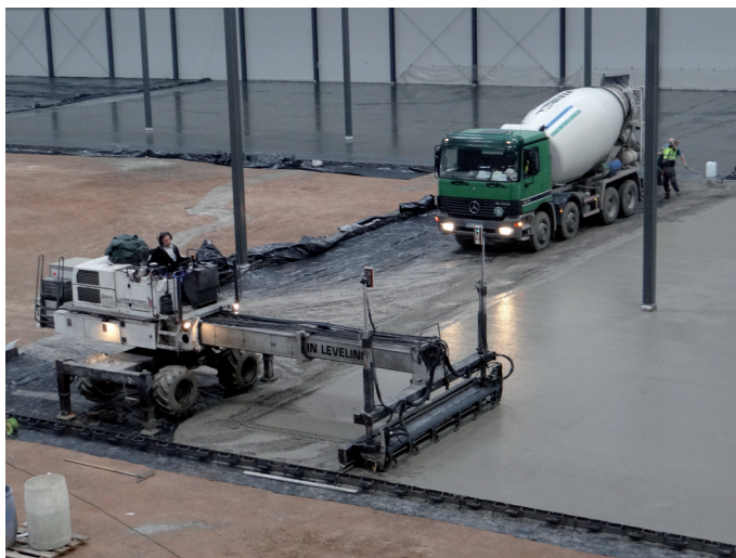
Fot. 3. Mechaniczne układanie mieszanki kompozytywnej
