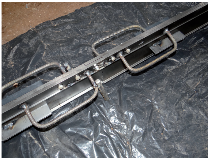
Fot. 2. Profile dylatacyjne z dyblami
