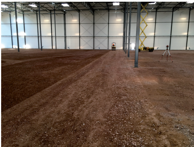
Fot. 1. Podbudowa zasadnicza z kruszywa łamanego stabilizowanego mechanicznie
