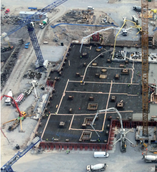
Fot. 1. Zabudowa betonu w konstrukcji masywnej
