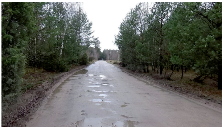
Fot 8. Stan DW 272 przed przebudową (Archiwum LafargeHolcim)
