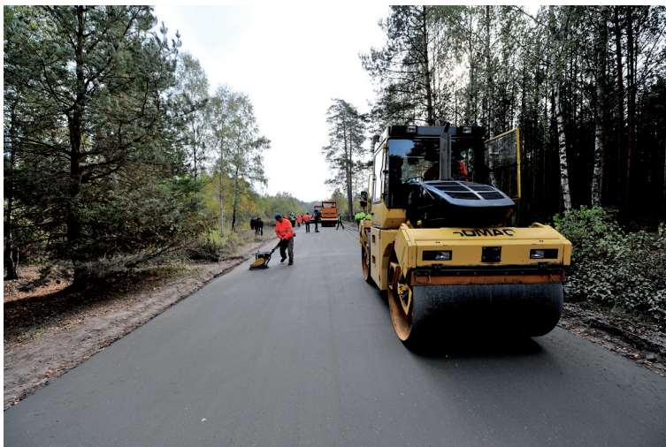
Fot 9. DW 272 – wałowanie wbudowanej już mieszanki betonowej (Archiwum LafargeHolcim)
