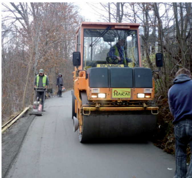
Fot. 1. Pierwsza droga z betonu wałowanego w Polsce (autor foto: Konrad Harat)
