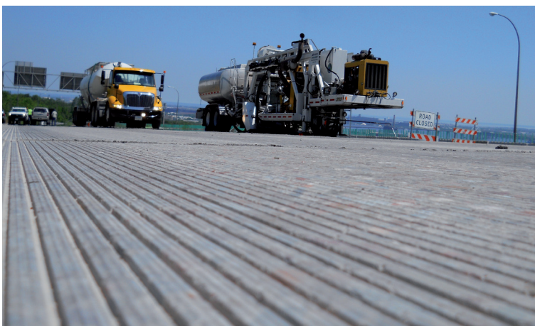
Fot 11. Nawierzchnia betonowa ulepszona metoda NGCS
