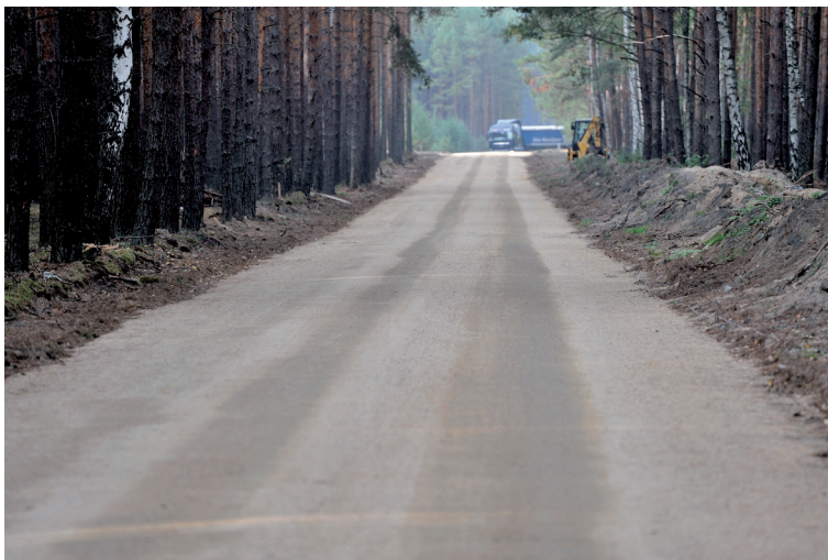
Fot. 4. Przygotowane podłoże pod warstwę betonu wałowanego. Podbudowa pomocnicza – 10cm z grunto-cementu 2,5 MPa + 25 cm mieszanka 0/31,5 (Archiwum LafargeHolcim)
