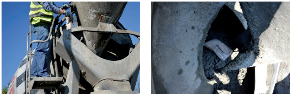
Fot. 1. Dozowanie domieszki DYNAMON RT POWDER do mieszalnika betonomieszarki
