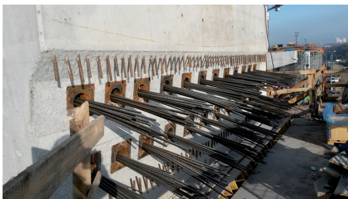
Fot. 5. Widok strefy zakotwień kabli sprężających rygla podpory H, strona prawa
