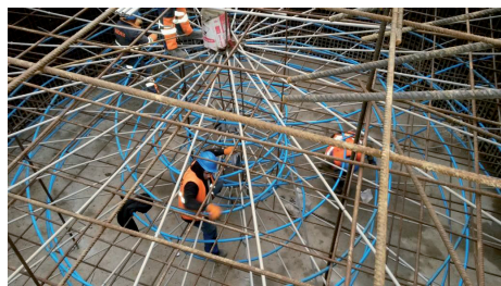
Fot. 3 i 4. Instalacja chłodzenia wewnętrznego słupów
