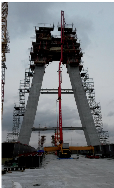
Fot. 6. Formowanie ostatniego segmentu 50-metrowego pylonu
