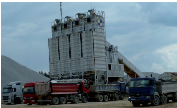
Fot. 4. Wytwórnia betonu nawierzchniowego o produkcji ciągłej, w której wytwarzane były mieszanki betonowe do GWN i DWN [fot. M. Konopska-Piechurska]
