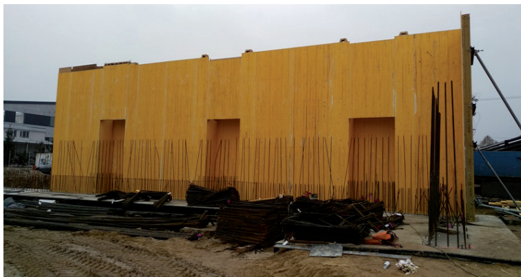
Fot. 1. Deskowanie przyczółku wykonane ze sklejki trójwarstwowej
