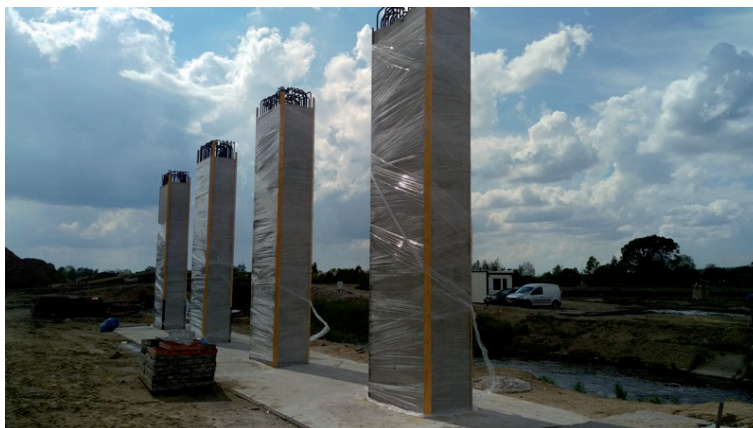
Fot. 5. Słupy zabezpieczone folią niestykającą się z powierzchnią betonu
