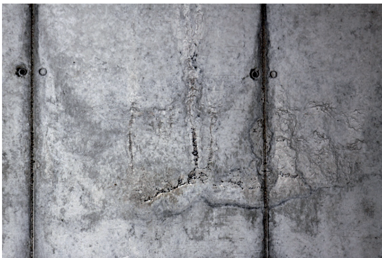
Fot. 7. Efekt rozsegregowania mieszanki na powierzchni elementu
