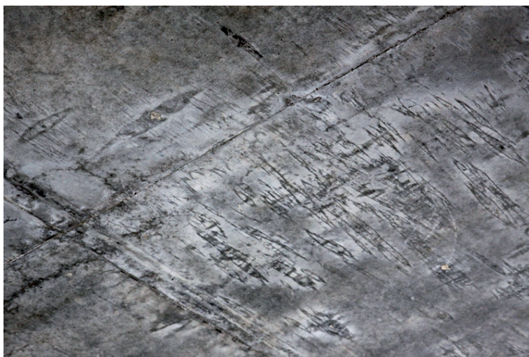
Fot. 9. Wady powierzchni powstałe w wyniku zastosowania sklejki o niskiej jakości
