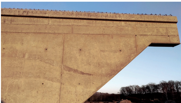
Fot. 1. Przyciółek z widocznymi przewarstwieniami
