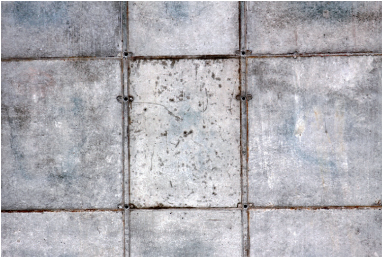
Fot. 2. Efekt zastosowania deskowania o różnej jakości powierzchni
