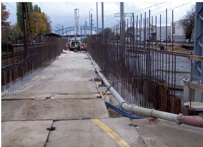
Fot. 3. Fragment rurociągu
