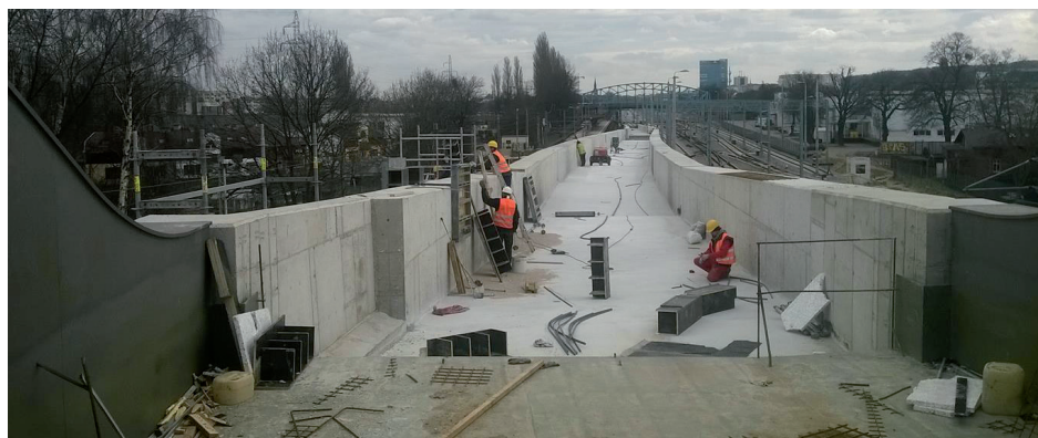
Fot. 6. Widok na mur oporowy
