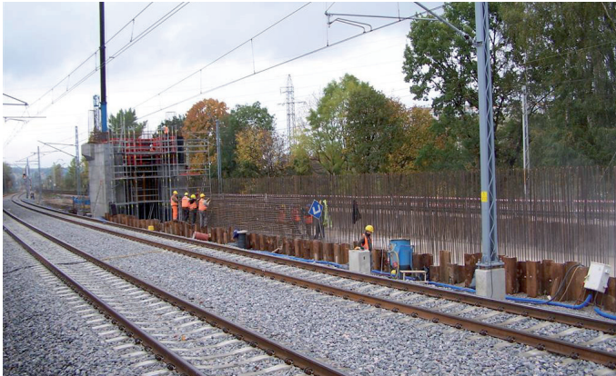
Fot. 1. Montaż zbrojenia muru M-1
