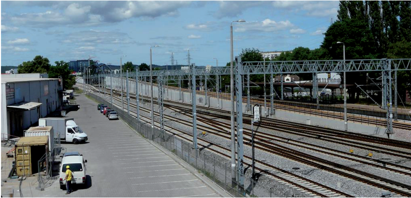
Fot. 8. Widok na gotowy mur oporowy i stację kolejki SKM Gdańsk–Zaspa
