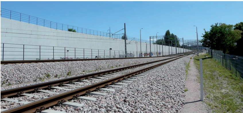
Fot. 9. Widok na gotowy mur M-1
