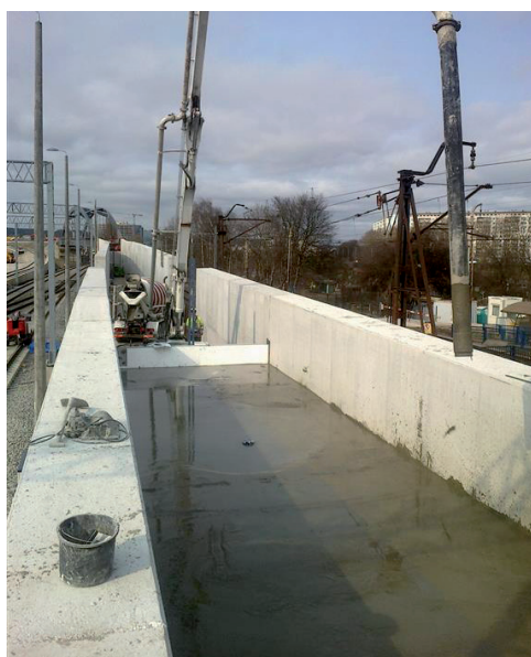
Fot. 7. Pompowanie betonu wypełniającego B7,5
