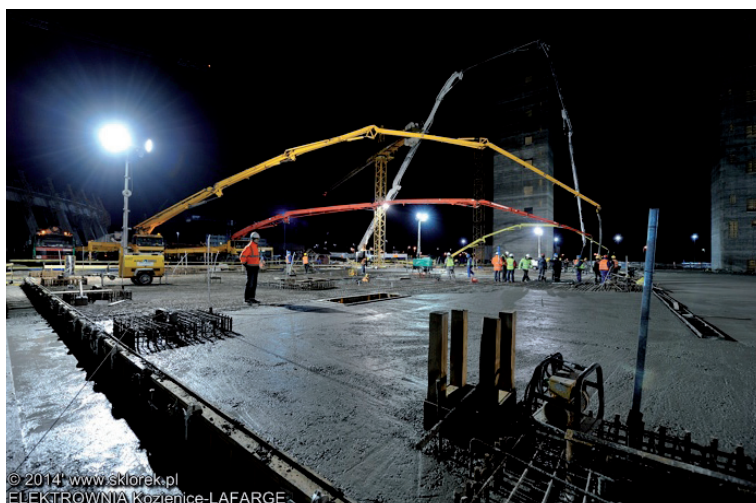
Fot. 3. Zdjęcie z realizacji
