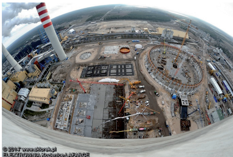
Fot. 2. Zdjęcie z realizacji
