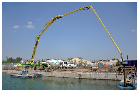
Fot. 5. Dostawy betonu na budowę [zdjęcie autora]
