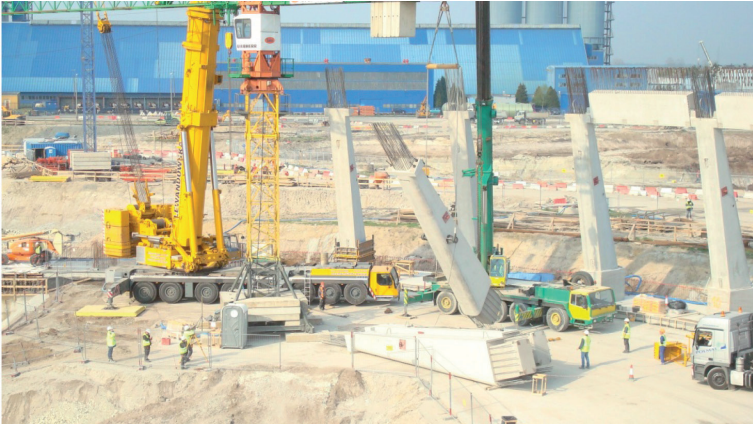
Rys. 10. Prefabrykowane słupy konstrukcji wsporczej podczas montażu na fundamencie pierścieniowym [1]
