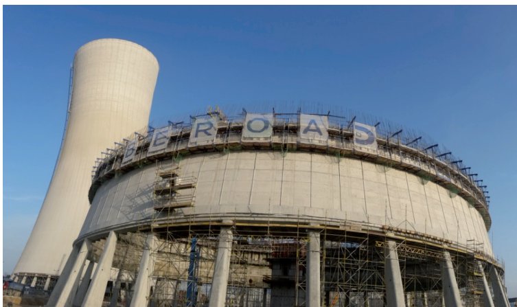
Rys. 6. Konstrukcja wsporcza w trakcie realizacji płaszczu chłodni kominowej 6URA, w tle chłodnia 5URA [1]
