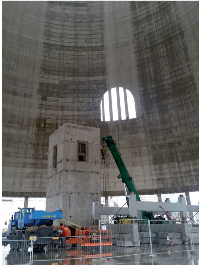
Rys. 14. Prefabrykaty przestrzennych ram wsporczych wewnątrz chłodni – na pierwszym planie
