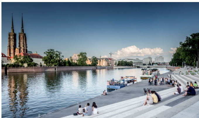
Fot. 7. Bulwar Dunikowskiego w trakcie oraz po zakończeniu realizacji
