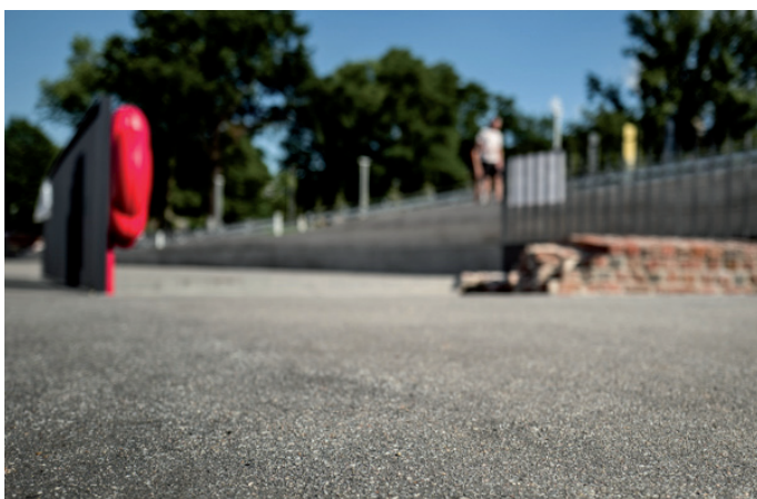
Fot. 8–10. Bulwar Dunikowski w trakcie oraz po zakończeniu realizacji
