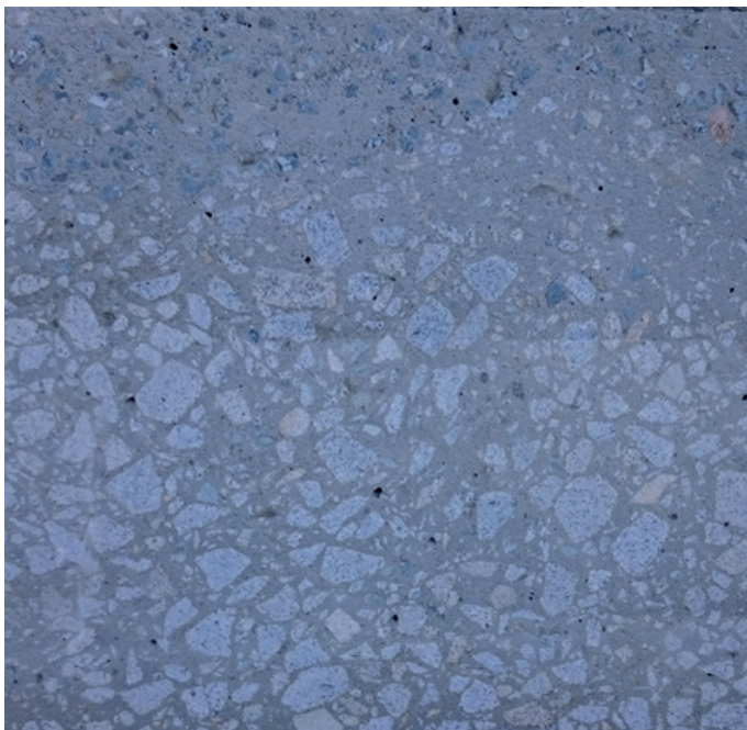
Fot. 2. Przekrój przez nawierzchnię cementową autostrady A-1, zadanie II odcinek od km 310 + 000 do km 320 + 010
