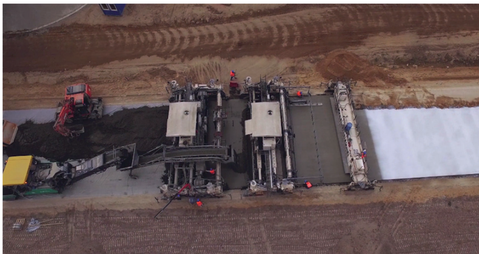
Fot. 3. Układanie nawierzchni cementowej
