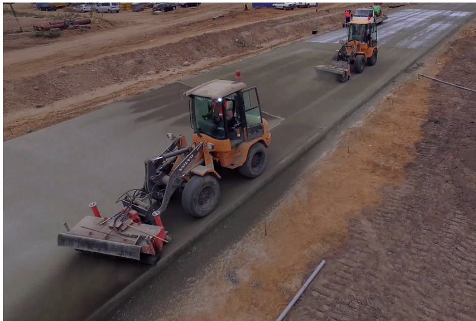
Fot. 4. Szczotkowanie wierzchniej warstwy nawierzchni cementowej
