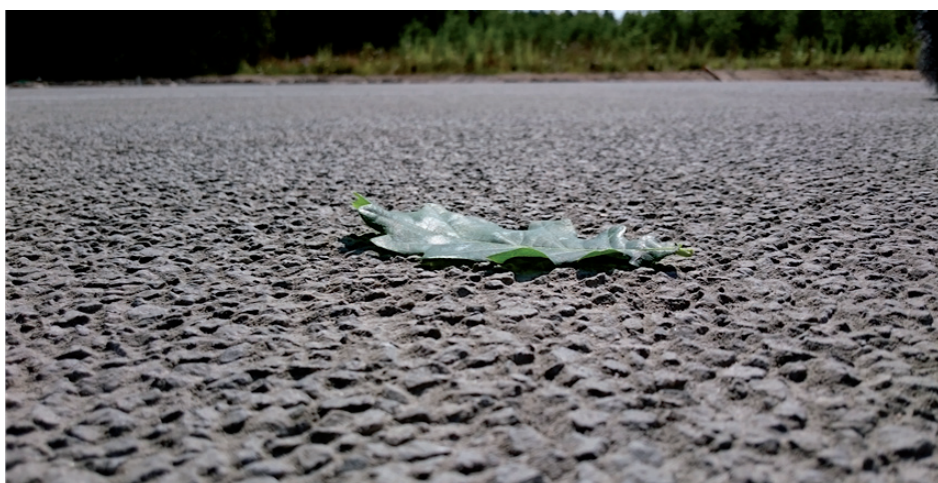
Fot.1. Powierzchnia nawierzchni betonowej z eksponowanym kruszywem
