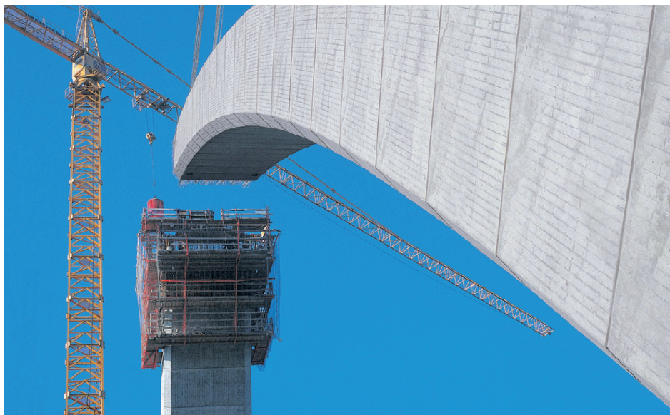
Fot. 3. Odcisk deskowania z poszyciem z desek
