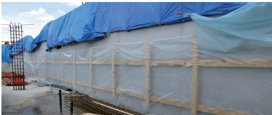
Fot. 2. Zabezpieczenie przed uszkodzeniem i pielęgnacja
