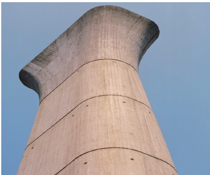
Fot. 4. Filar wykony w deskowaniu specjalnym PERI
