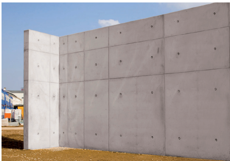
Fot. 6. Odcisk ram deskowania PERI MAXIMO
