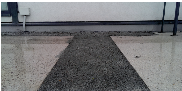
Fot. 2. Beton przepuszczalny jako drenaż
