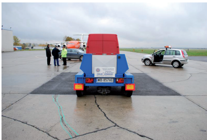
Fot. 4. Pomiar ugięć sprężystych płyty wymienionej w technologii betonu wałowanego
