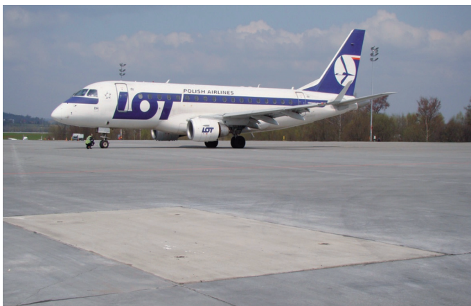
Fot. 1. Płyta prefabrykowana na nawierzchni lotniskowej PPS na lotnisku Kraków-Balice
