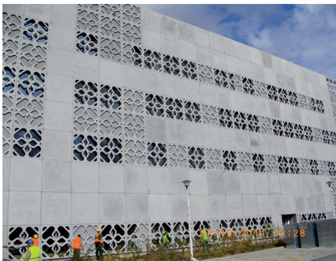
Fot. 2. Politechnika w Białymstoku, biblioteka, obiekt po oddaniu
