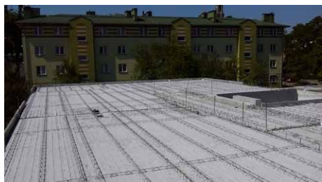
Fot. 6. Montaż stropu typu filigran
