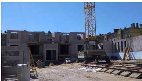
Fot. 7. Montaż ścian budynku na drugiej kondygnacji – 03.07.2015
