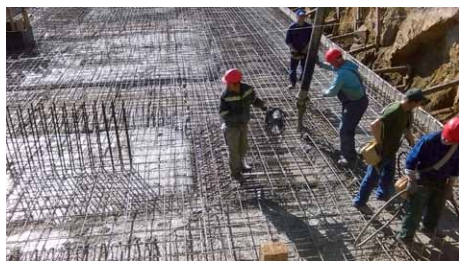
Fot. 2. Płyta fundamentowa – 15.04.2015
