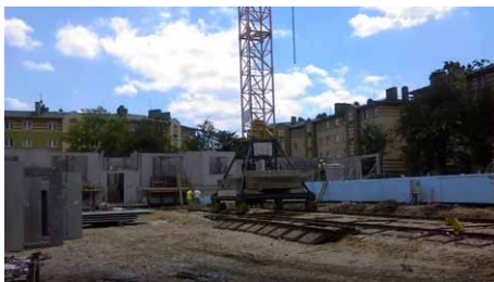
Fot. 5. Montaż ścian budynku na pierwszej kondygnacji – 16.06.2015
