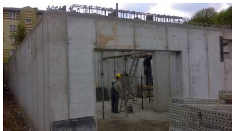
Fot. 4. Ściany garażu podziemnego – 27.04.2015
