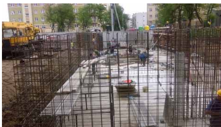
Fot. 3. Zbrojenie ścian piwnicy – 22.04.2015
