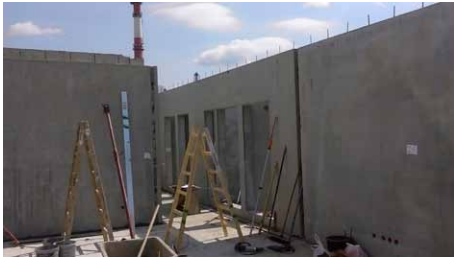
Fot. 10. Montaż ścian budynku na czwar- tej gotowe łącznie ze ścianami działowymi -10.09.2015
