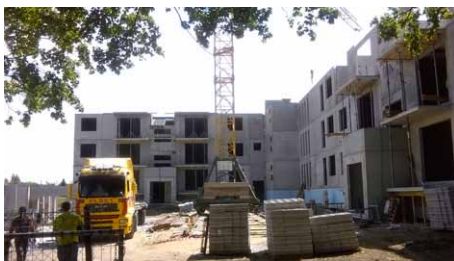
Fot. 9. Montaż ścian budynku na trzeciej kondygnacji – 03.08.2015
