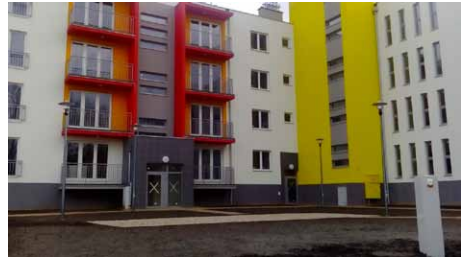
Fot. 11. Stan deweloperski po 10 miesiącach od rozpoczęcia prac – 15.12.2015
