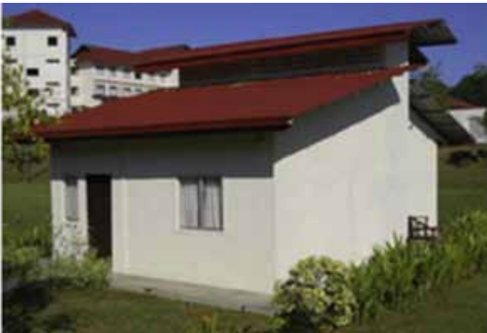
Rys. 10. Tani dom z lekkiego betonu z kruszywem z łupin palmy olejowej [33]
