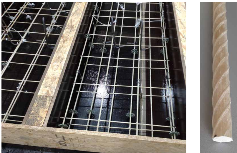
Rys. 5 Zbrojenie płyty przed betonowaniem
